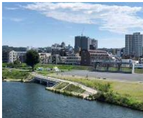
五反田川放水路整備事業
